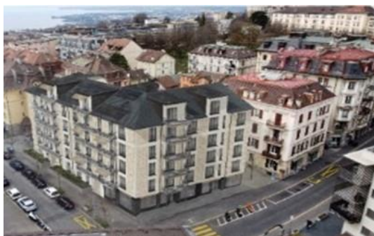
Rénovation d'un immeuble résidentiel Av. Jomini, Lausanne Volume d'investissement env. CHF 15 mio Achèvement au 4 e trimestre 2028
